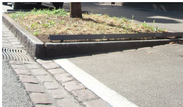
Abb. 203.05a Ausgeführtes Werk Rabattenschutz
