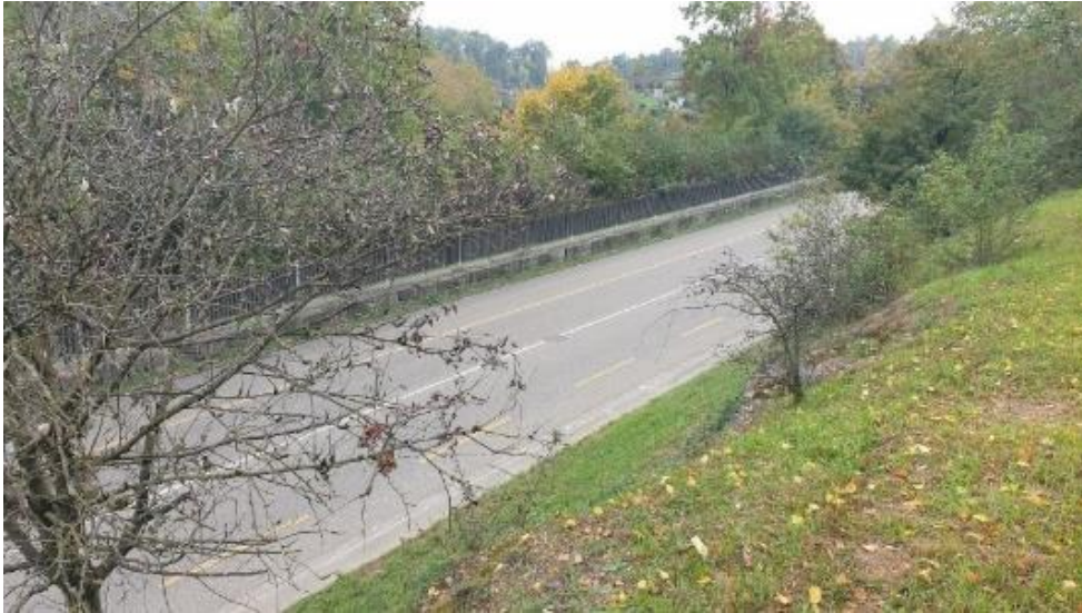
Abbildung 33: Böschung und auf der gegenüberliegenden Seite die Lärmschutzwand. Position: 2'612'102.0, 1'263'599.9
