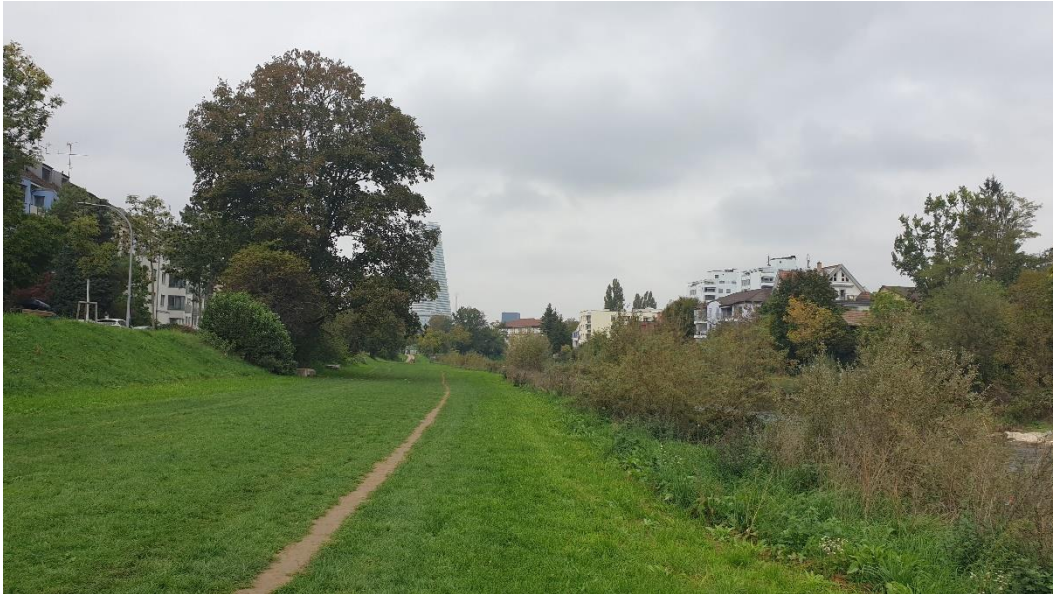
Abbildung 21: Birs mit Ufervegetation, darunter Blocksteine und anschliessend breitem Wiesenstreifen mit Fussweg. Position: 2°613'691.1, 1°266'861.5
