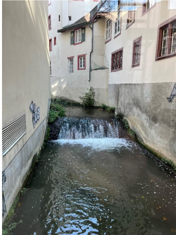
Abbildung 24: St. Alban-Teich nahe dem Zufluss in den Rhein. In diesem Abschnitt verläuft er zwischen Häusern und hat grosse Schwellen. Position: 2°612'247.4, 1°267'104.9
